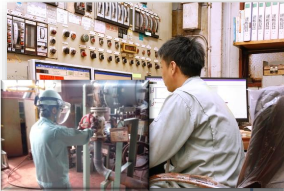
塩酸回収コントロール室
